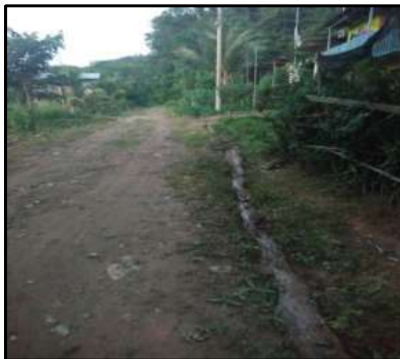
Se observa la localidad de Gregorio, y la plataforma de la carretera antes de la intervención vial.
