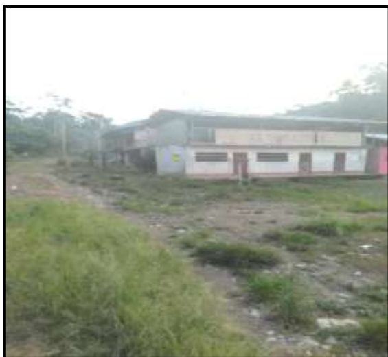
Se observa la vía vecinal, a un costado un centro educativo nivel inicial en la localidad de Bolayna, antes de la intervención vial.
