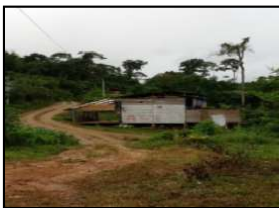
Se observa la localidad de Alto Inkari, antes de la intervención vial
