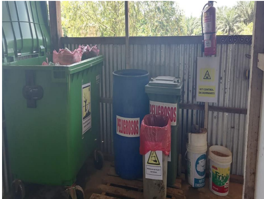
Figura 42. Implementación de kit anti derrame y extintor en el almacén de peligrosos
