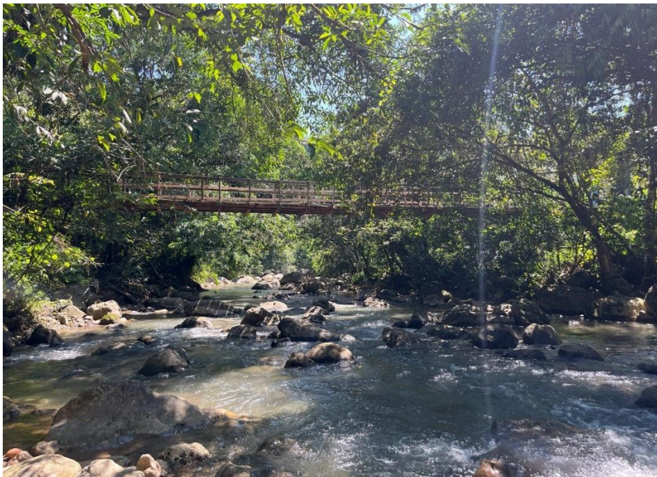
Figura 46. Toma del puente peatonal en el centro poblado
