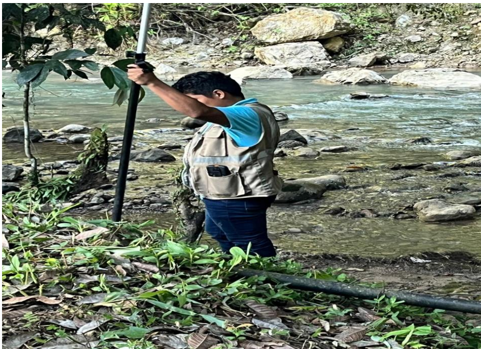
Figura 29. Toma 1 de obtención de puntos del tirante margen derecho del río Las Pavas
