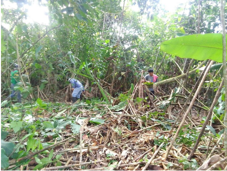
Figura 17. Desbroce y corte de árboles aplicando el Refinamiento en el T2
