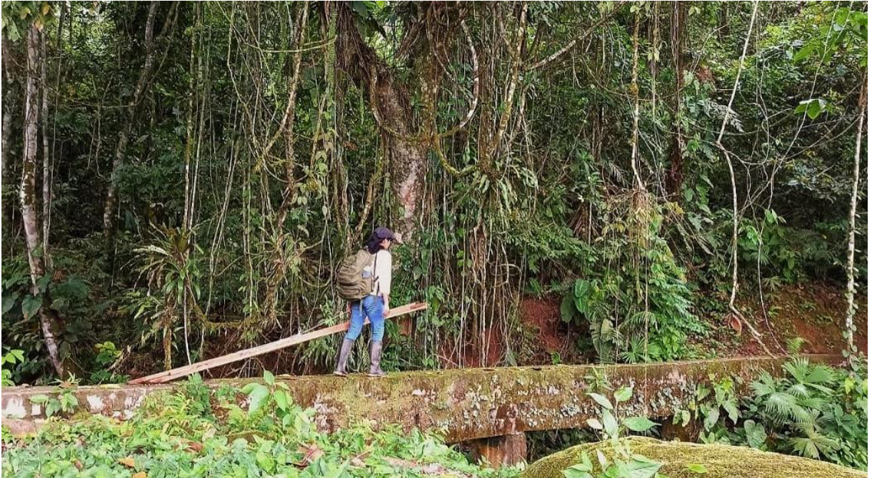
Figura 6. Traslado de postes
