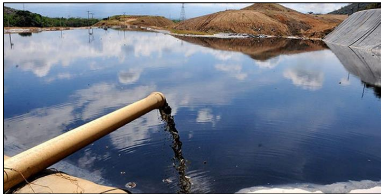
Figura 1. Acumulación de lixiviados
