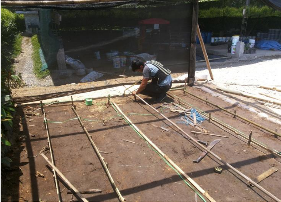
Figura 9. Construcción de vivero
