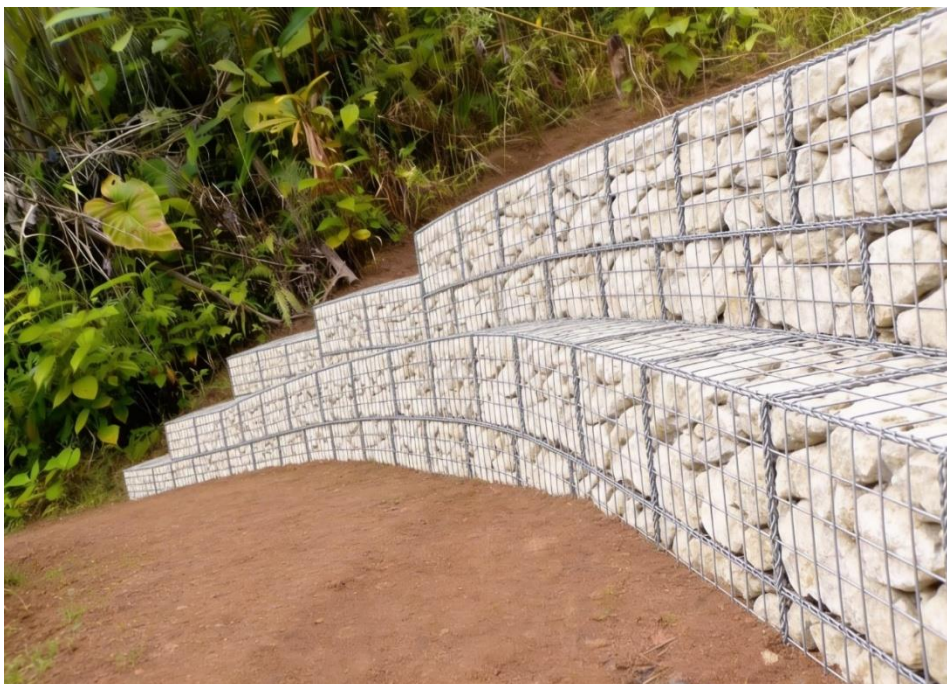
Figura 38. Construcción de muro de gaviones borde ríos y carreteras
