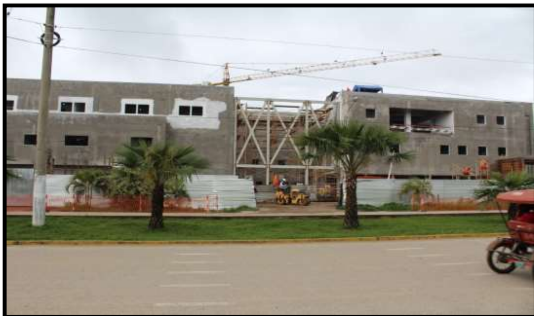
Etapa de construcción Hospital de Tocache, Provincia de Tocache – Región San Martín
