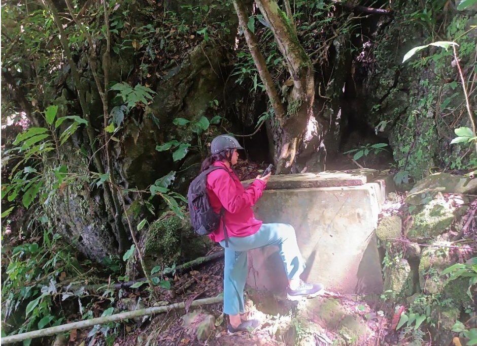
Figura 27. Verificación de la infraestructura del sedimentador.
