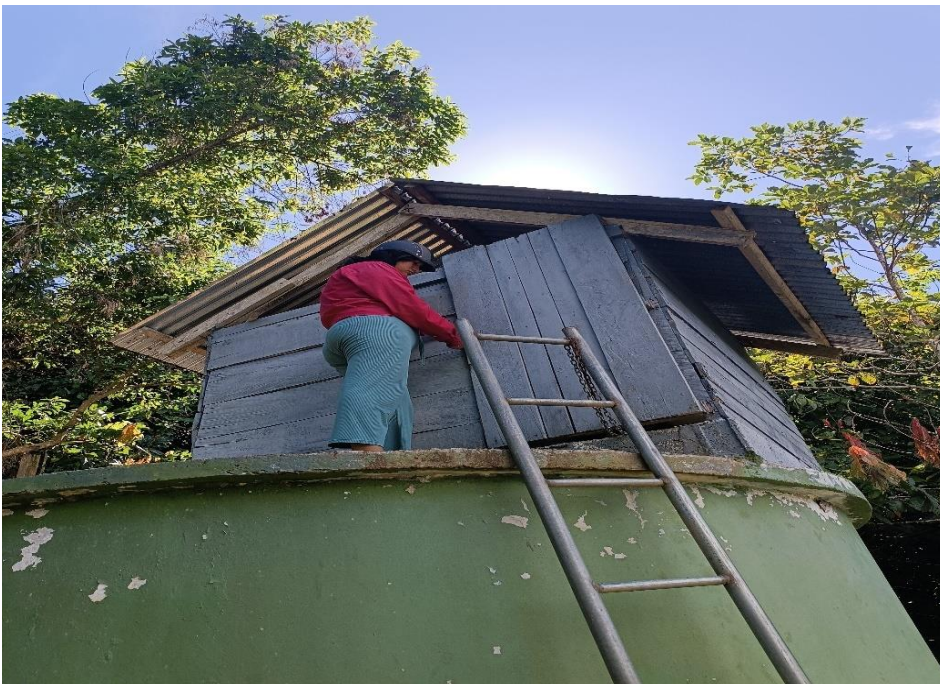
Figura 28. Reconocimiento e inspección del reservorio de picuroyacu
