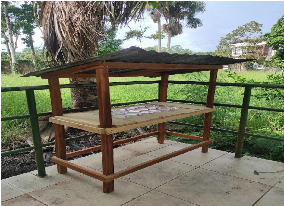
Figura 26. Instalacion de Placas receptoras P2 Diciembre 2023
