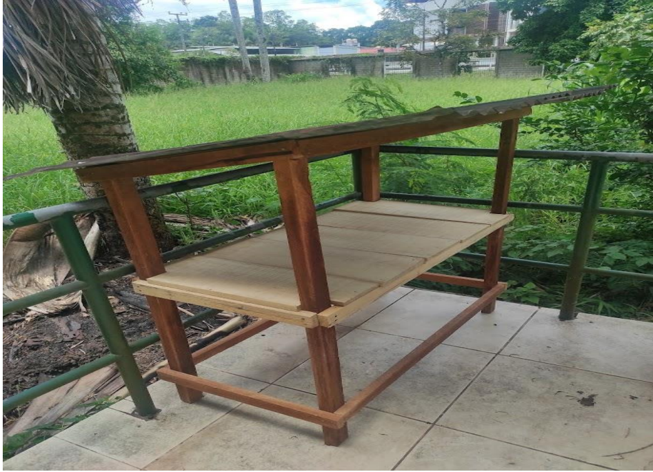
Figura 31. Instalación del Soporte de placas receptoras
