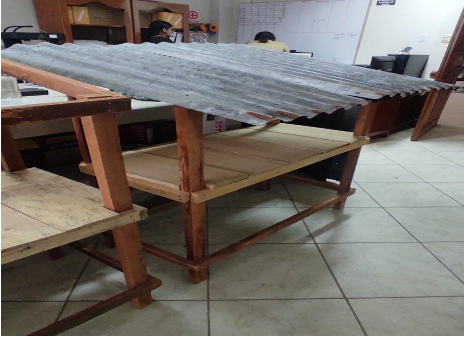
Figura 41. Armado del Soporte de placas receptoras
