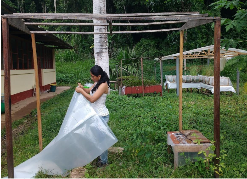
Figura 10. Instalación del techo.
