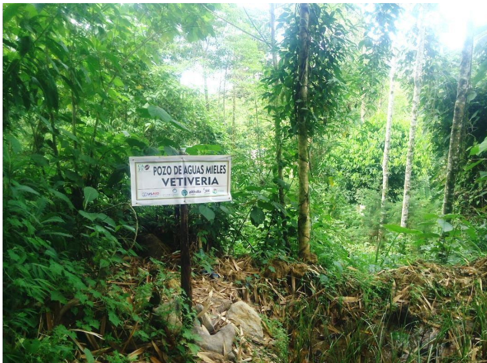
Figura 51. Pozo de tratamiento de aguas mieles con Vetiveria
