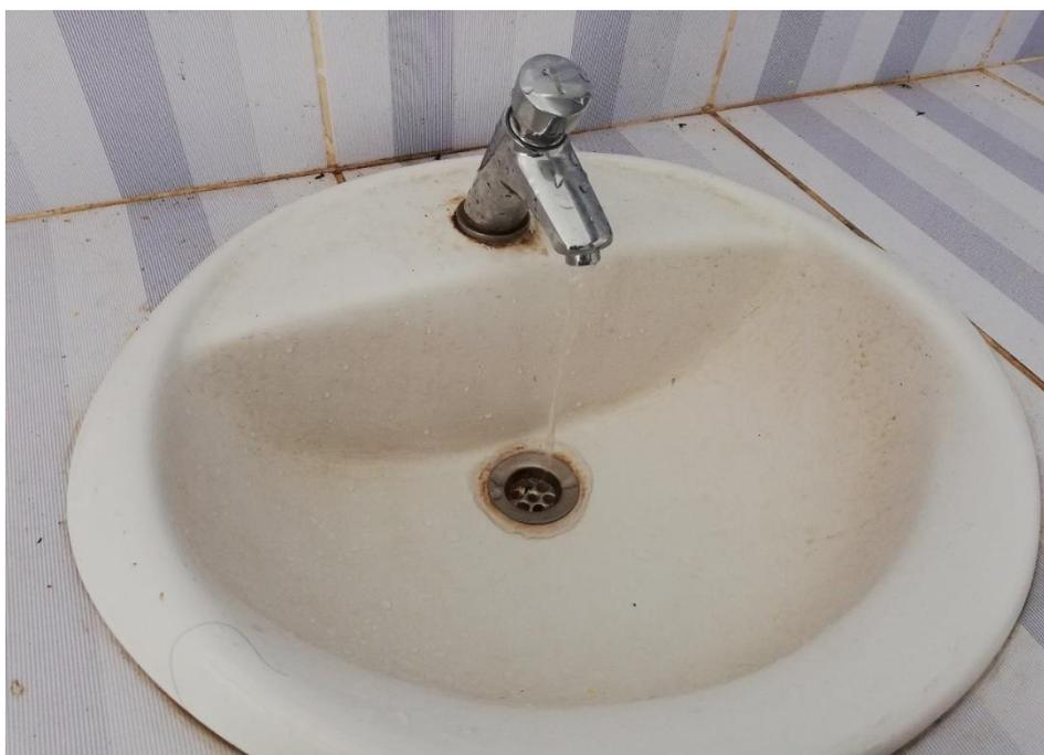
Figura 24. Fugas de agua en los servicios higiénicos remodelados.
