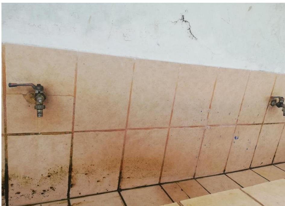
Figura 30. Grifos en mal estado y con averías en el Pabellón “Gallito de las Rocas”.
