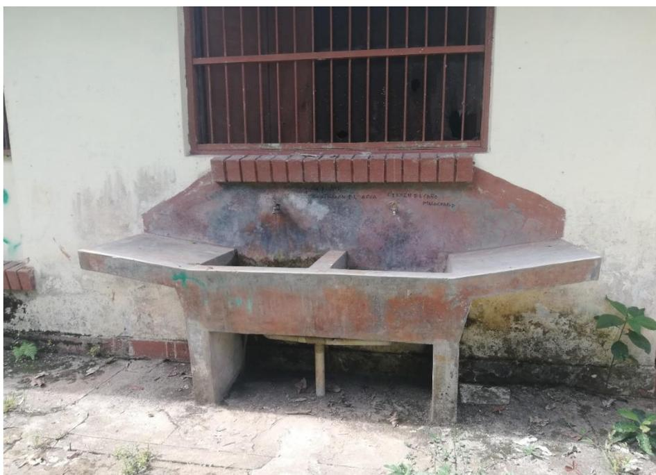
Figura 26. Deterioro de equipamiento sanitario en las ex viviendas de docentes (deshabitadas).
