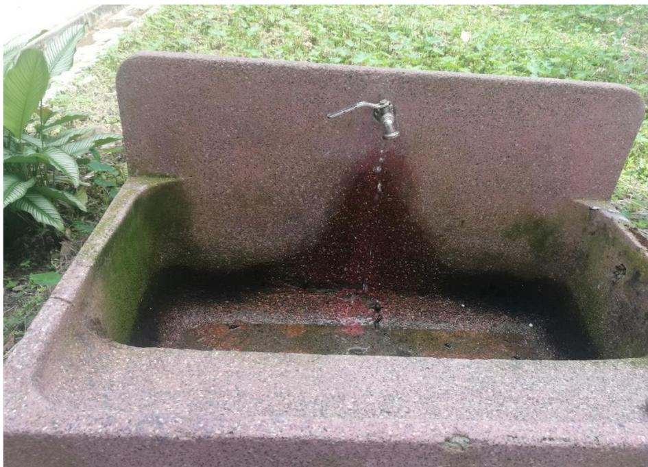
Figura 27. Fugas de agua y averías en el grifo que provee de agua al Laboratorio de Operaciones Unitarias (EPIA-FRNR).
