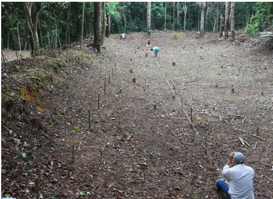
Figura 25. Labores de trazado y marcado.
