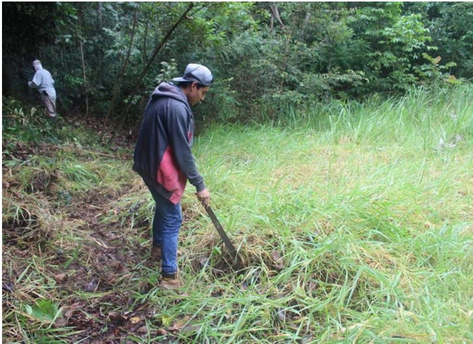
Figura 24. Limpieza mecánica de terreno.
