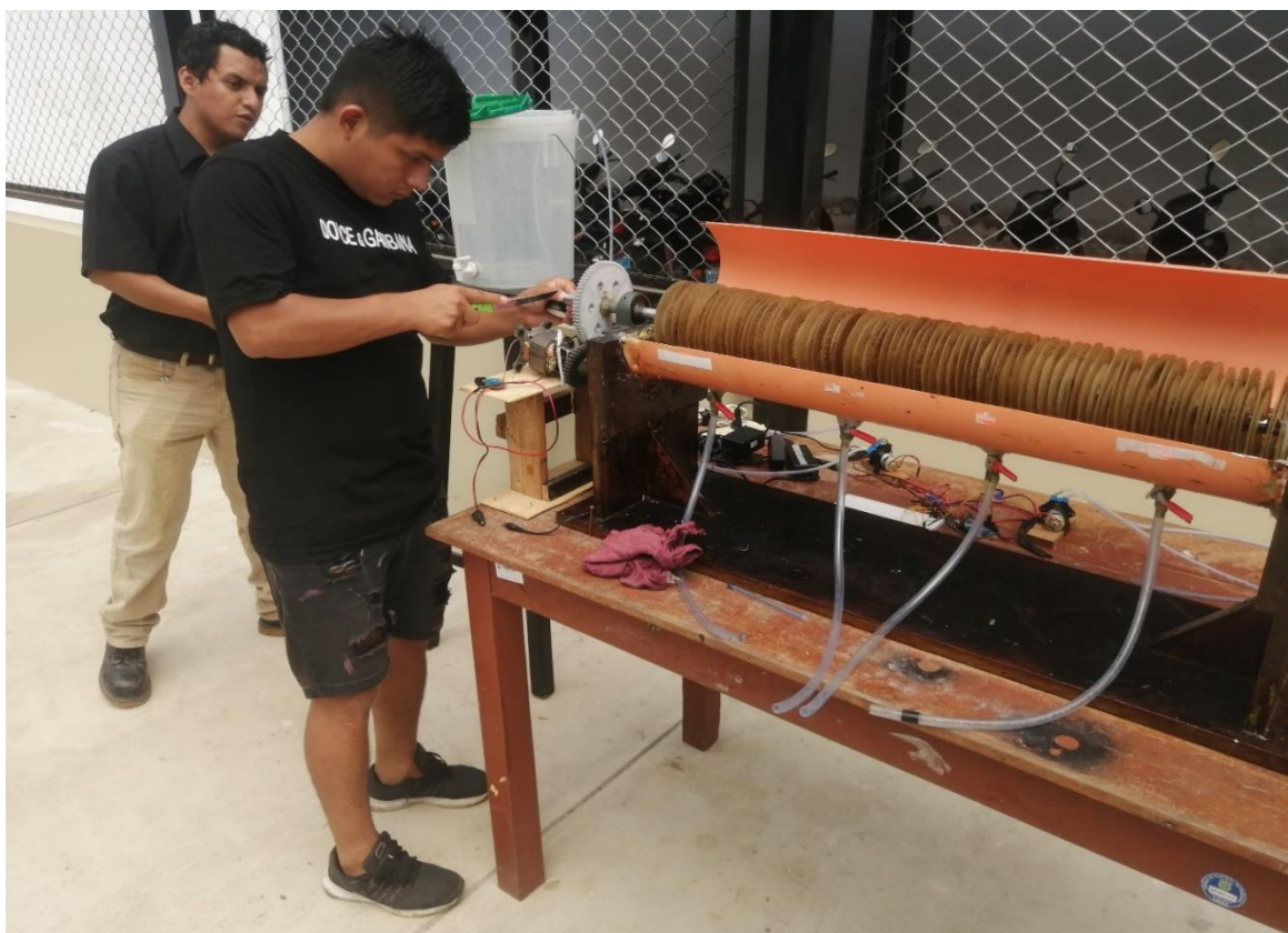
Figura 14. Construcción del sistema de Biodiscos
