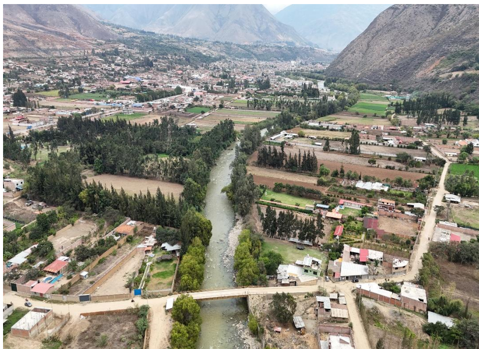
Figura 104. Vista aérea del puente Matibamba, aguas arriba.
