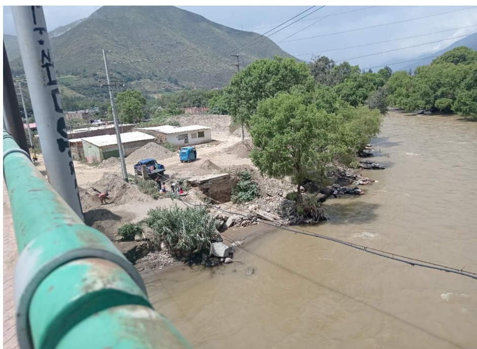
Figura 113. Captadores de sedimentos contruidos con costales y extracción de arena en el margen del río Huallaga, puente “Colpa Alta”
