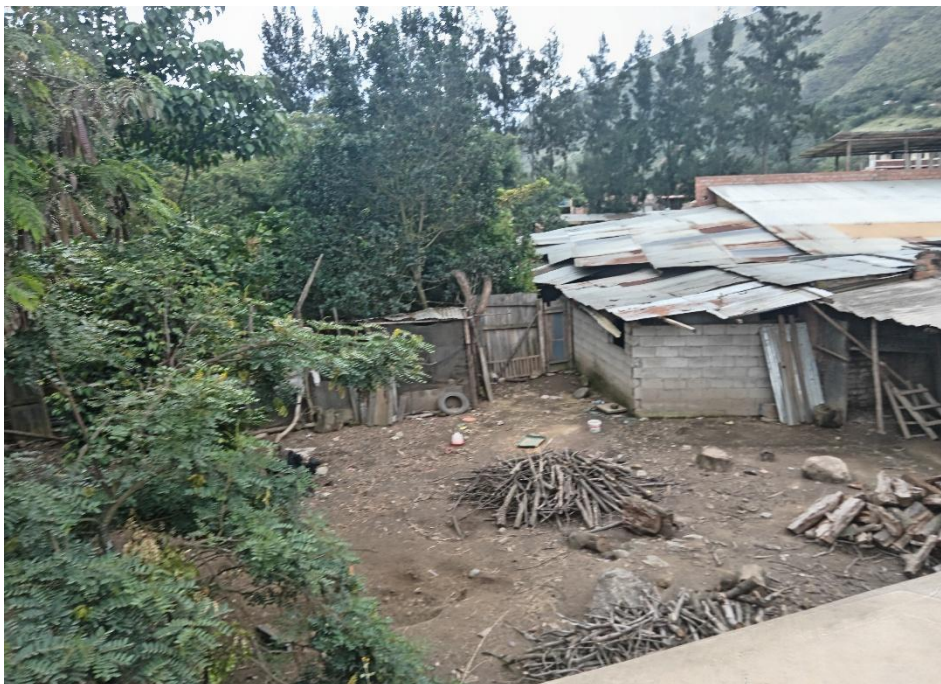
Figura 130. Viviendas de construcción precaria en la ribera del río en Matibamba
