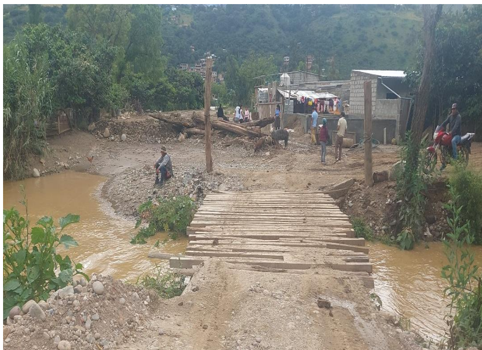
Figura 118. Viviendas afectadas por el desborde del río Huallaga y la quebrada Chicchuy en Colpa Alta
