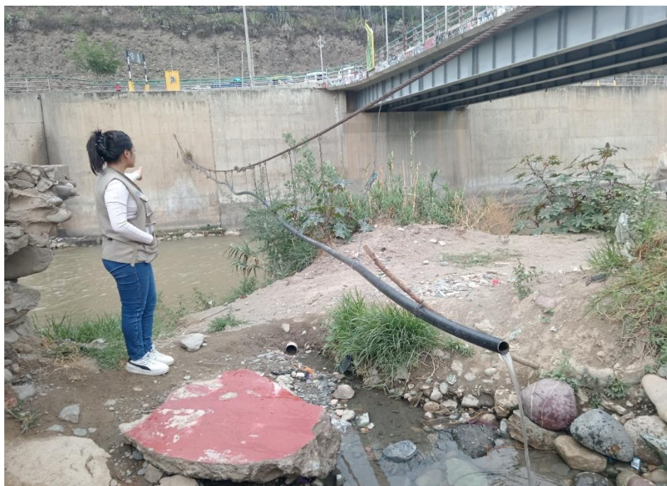
Figura 114. Tubería de sistema de abastecimiento de agua potable, expuesta
