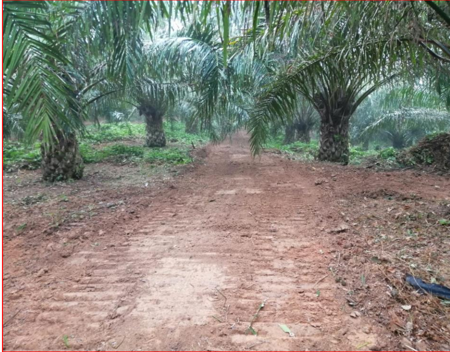
Figura 15. Carretera interna perfilada de 3 m de ancho.
