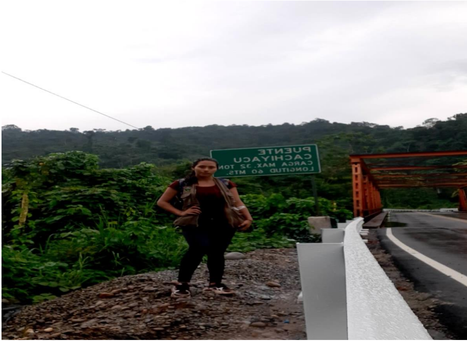
Figura 117. Vista panorámica del puente Cachiayacu.
