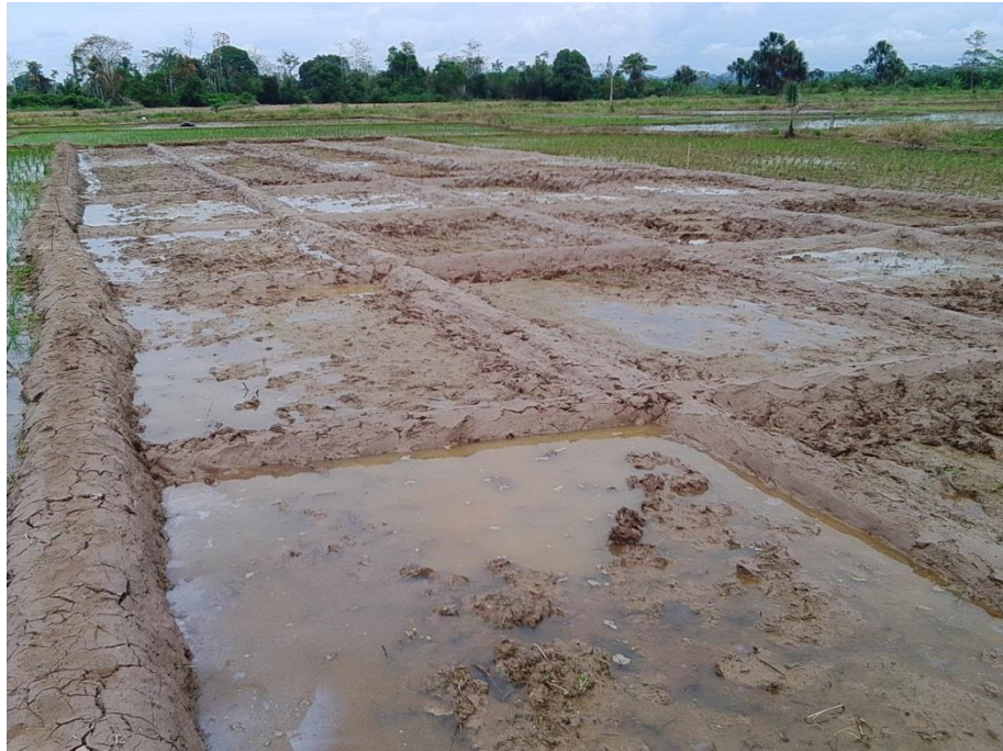
Figura 9. Preparación del terreno.
