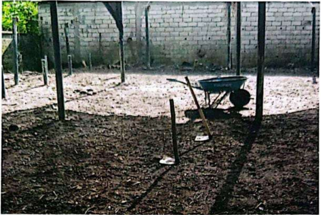
Figura 16. Preparación del terreno para la instalación del vivero.
