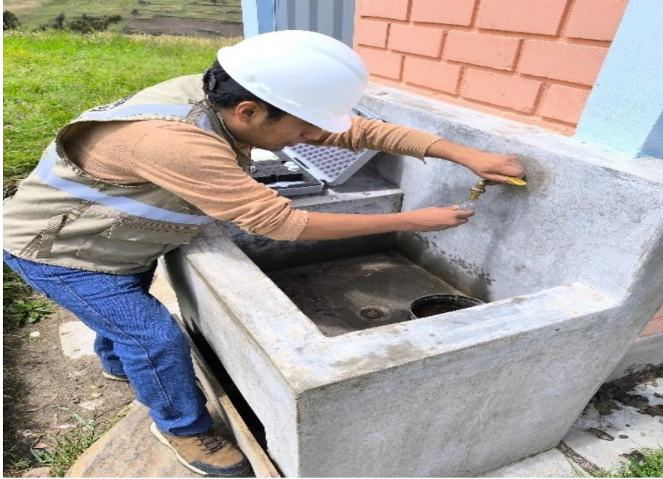
Figura 29. Toma de muestra para medición del cloro residual.
