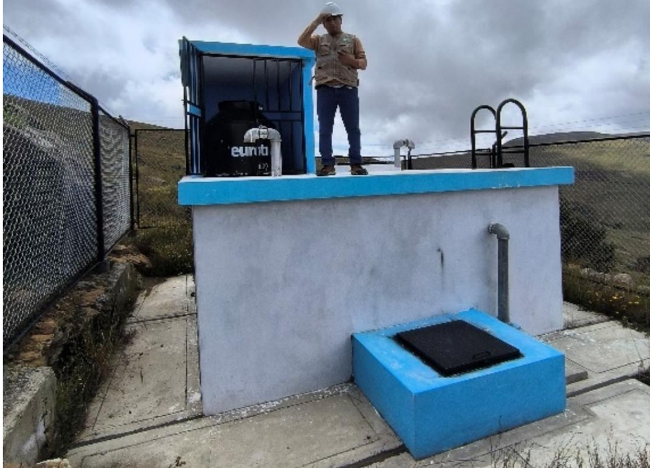
Figura 25. Reconocimiento del reservorio y caseta de cloración
