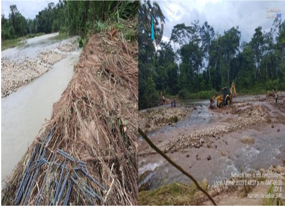
Figura 49. Inundación por desborde de río afectando el camino vecinal Puerto Inca-Puerto Sira y la atención con intervención de maquinaria pesada.
