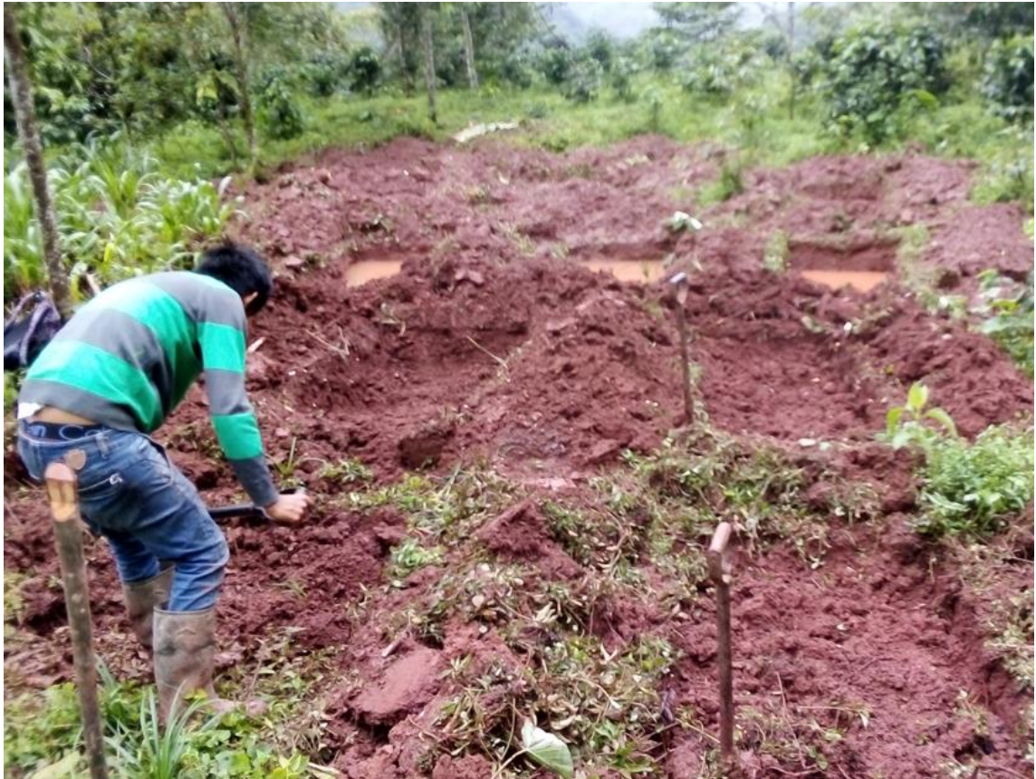
Figura 18. Limpieza del terreno en el bloque II.
