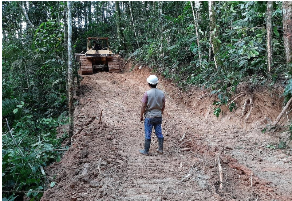
Figura 4. Apertura de caminos forestales en el aprovechamiento forestal.
