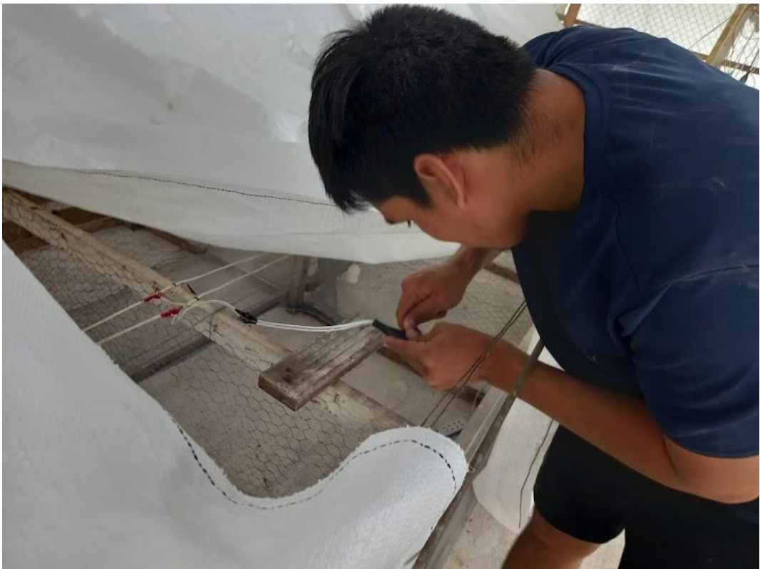
Figura 4. Instalación de luz.
