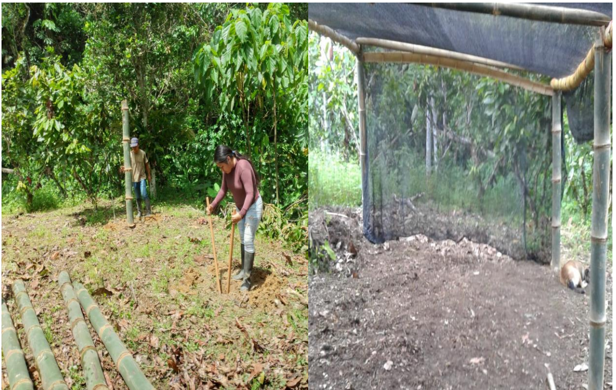
Figura 14. Construcción del tinglado y colocación de malla Raschel color negro.
