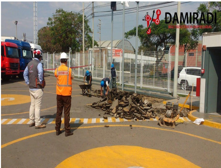
Figura 24. Reparación de instalaciones sanitarias
