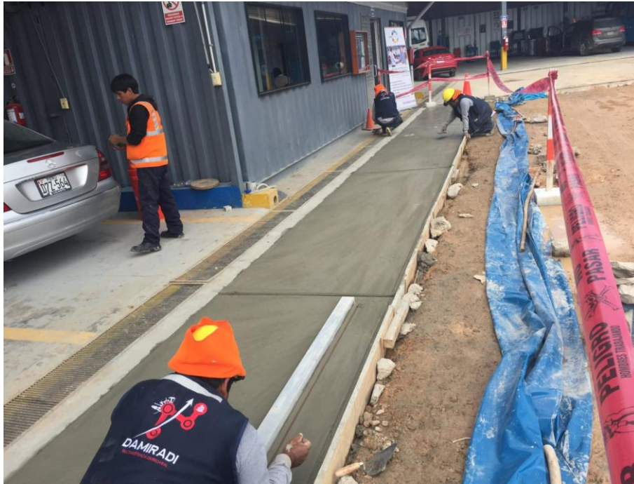
Figura 22. Mantenimiento de infraestructuras de construcción
