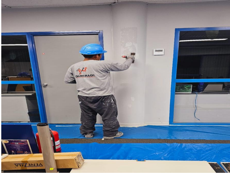
Figura 29. Mantenimiento de paredes de concreto en oficina
