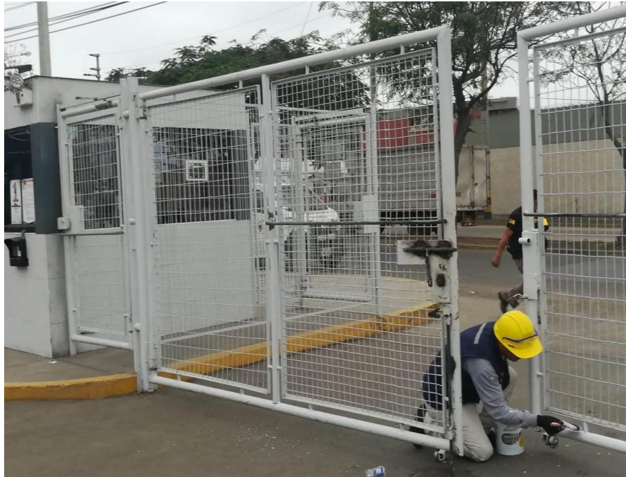
Figura 25. Mantenimiento de estructuras metálicas
