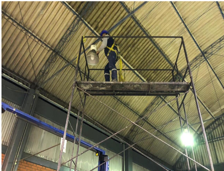
Figura 28. Mantenimiento de techos de estructura metálica
