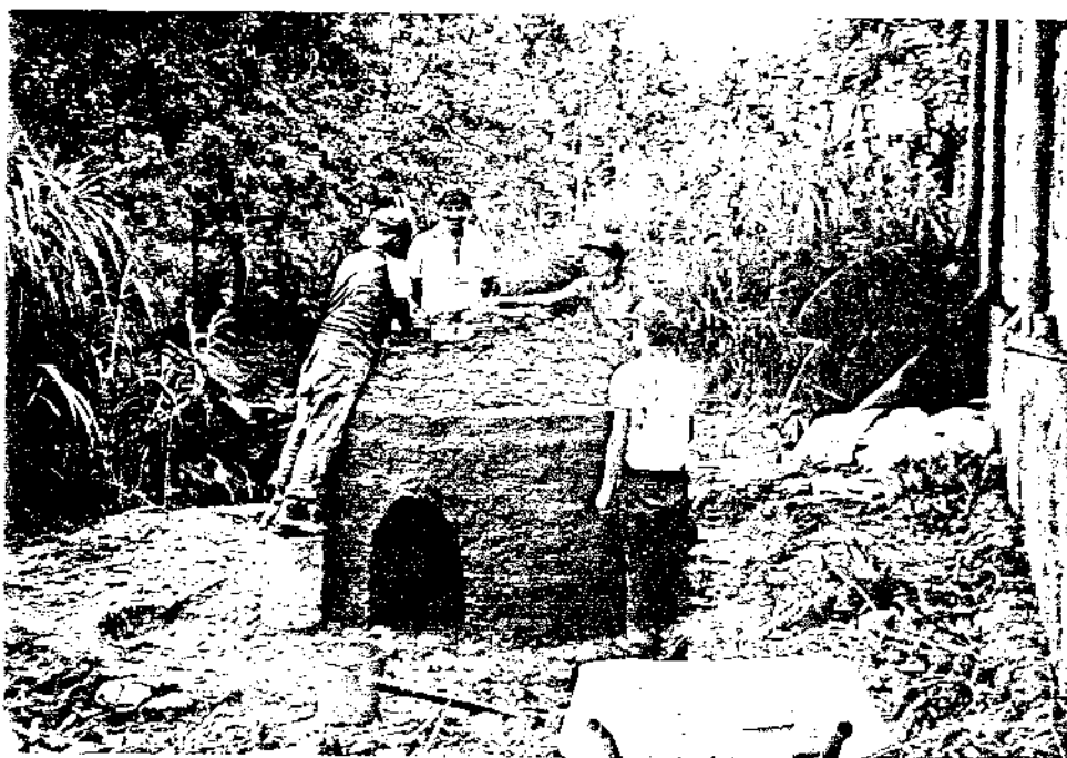
CULMINACION DE LA CONSTRUCCION DEL HORNO
