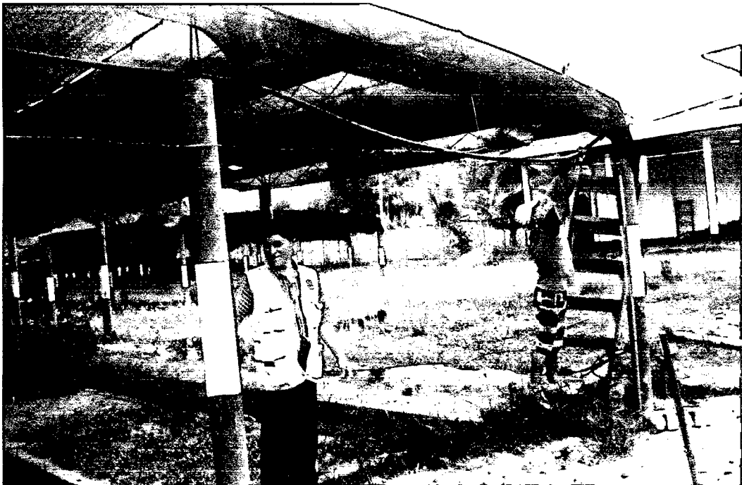
Figura 10. Instalación de la tubería terciaria.
