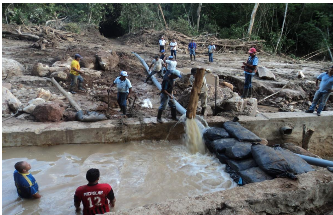
Figura 100. Trabajos de rehabilitación temporal de la captación Mishquiyacu y la línea de conducción de la captación Rumiayacu, 17 de noviembre del 2014
