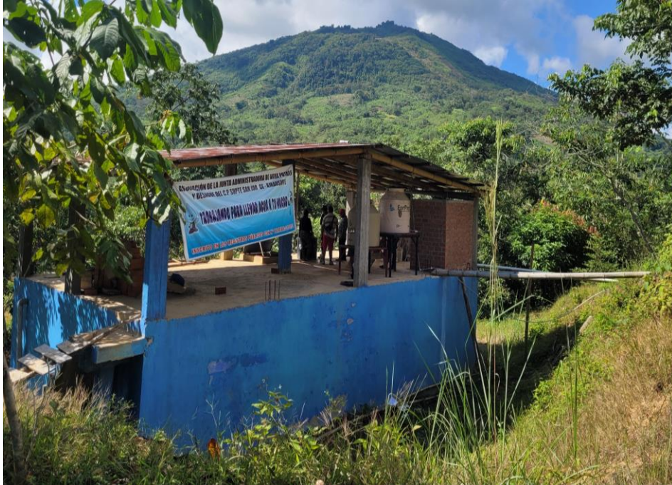
Figura 12. Identificación de la estructura de reservorio
