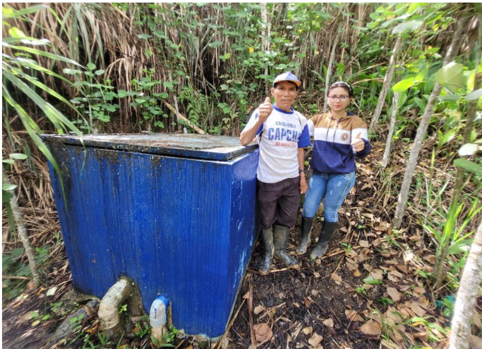
Figura 11. Reconocimiento de la estructura de captación
