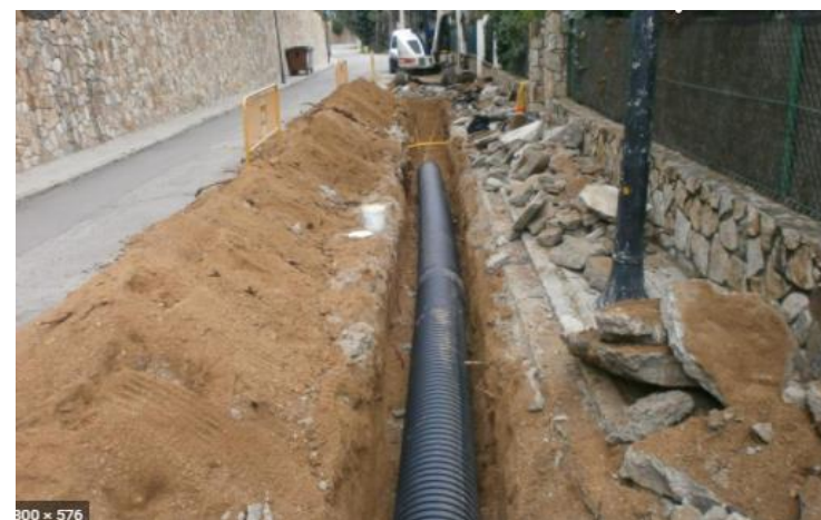
Figura 11: Sistema de distribución de agua.
