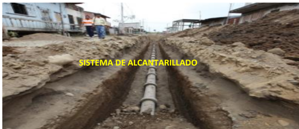
Figura 12: Sistema de alcantarillado.
