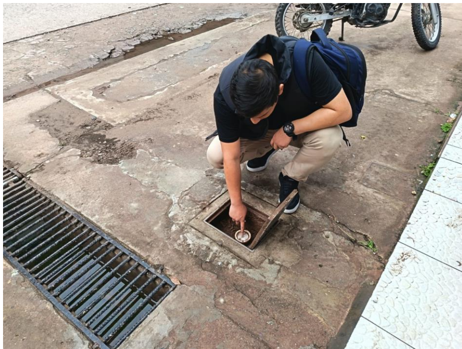
Figura 21. Verificando la caja de agua potable
